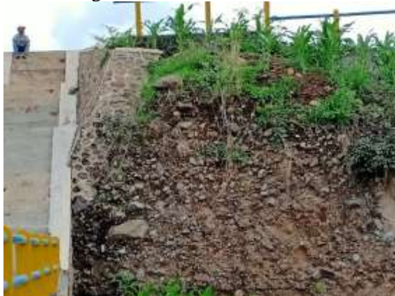
Gambar 11. Singkapan batu breksi di dinding tumpuan kiri
