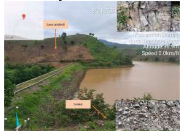
Gambar 18. Kondisi litologi di Bendungan Kesi
