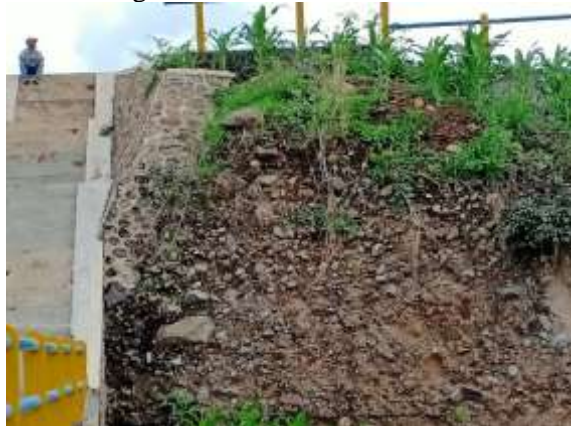
Gambar 11. Singkapan batu breksi di dinding tumpuan kiri
