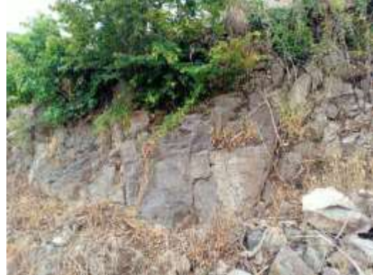
Gambar 12. Singkapan batu andesit dijumpai banyak rekahan di dinding tumpuan kanan
