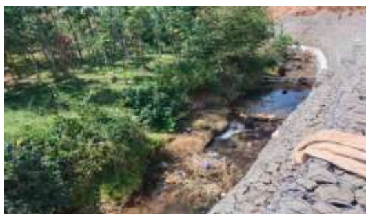
Gambar 1. Pemasangan bronjong kawat di Lereng Sungai Cilebakcawi
