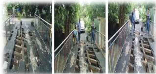
Gambar 26. Jembatan Pondok Karya 10
