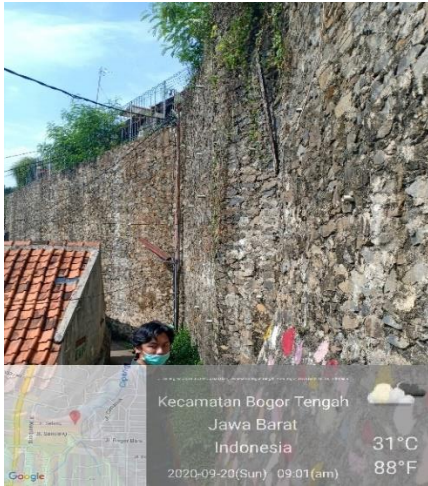
Gambar 5. Tembok Penahan Tanah Kondisi Tegak di belakang Café The Orange
