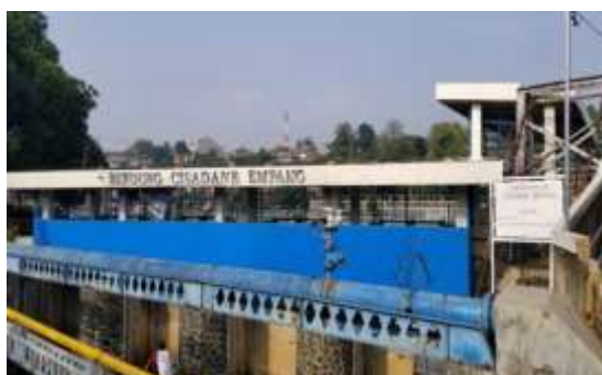
Gambar 2.3. Foto Bendung yang terdapat di Sungai Cisadane
