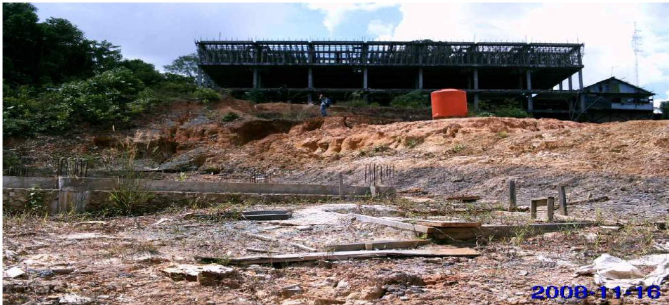
Gambar 6 Foto kelongsoran di lokasi pengamatan 01. Bagian yang berwarna hitam adalah batubara, batupasir yang berwarna kemerahan menumpang di atas batubara. (Jenis longsor yang terjadi adalah longsor dengan materi campuran antara masa tanah dan batupasir dan batubara yang meluncur mengikuti lereng.)
