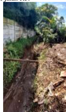
Gambar 4.6 Lahan kritis di Jalan R3 Kelurahan Katulampa
