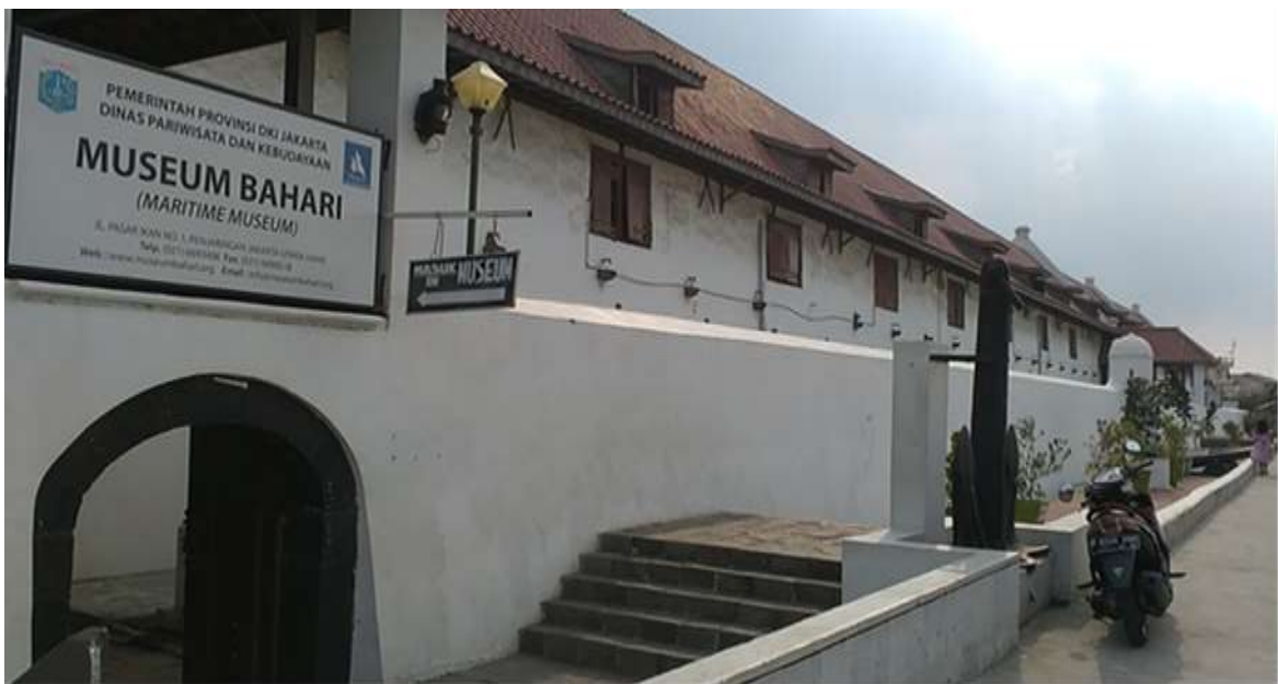
Gambar 3. Bangunan Gedung Museum Bahari Jakarta
